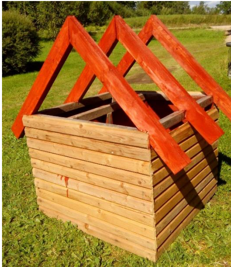
Joonis 4. Puiduimmutusvärviga värvitud kuut
